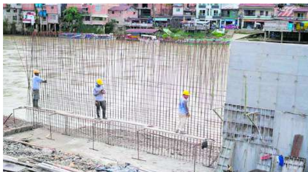
El muro de contención en el río San Juan en Itsmina será ampliado.
