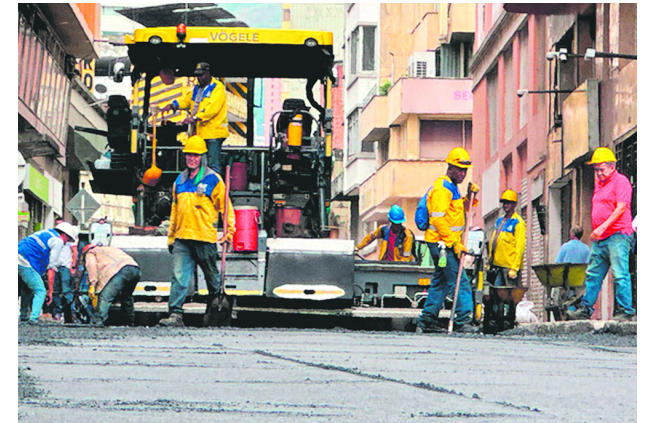
La recuperación de la malla vial en Cali avanza, pese a denuncias de sabotaje y desinformación.
