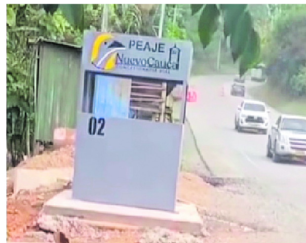
Esta imagen de las redes sociales muestra uno de los peajes antes de que fuera instalado.
